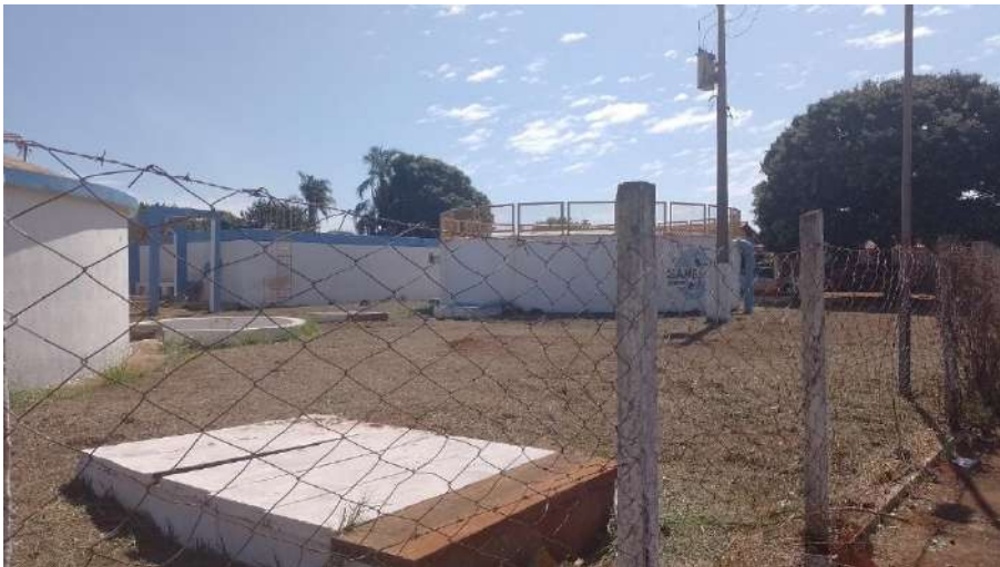
Figura 21: RST 2 e RAP 2 – Apoiado metálico.
