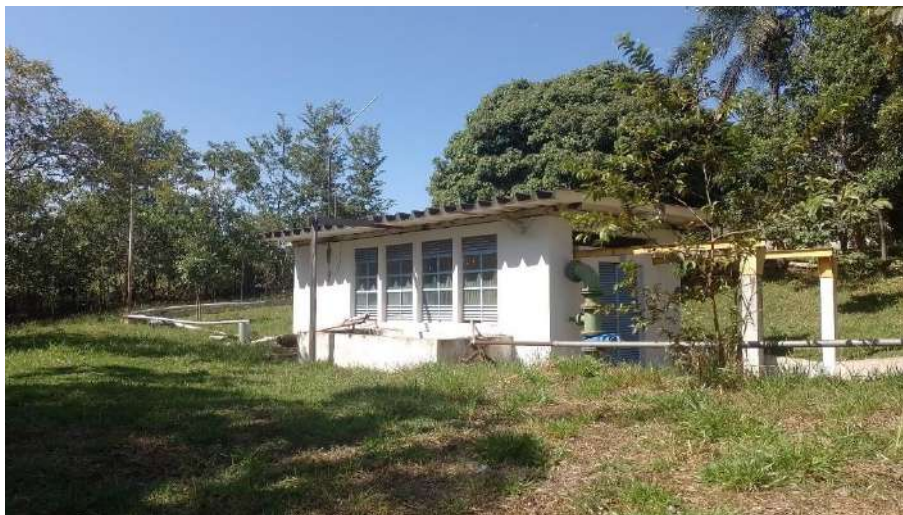
Figura 7: Estação Elevatória de Água Bruta.
