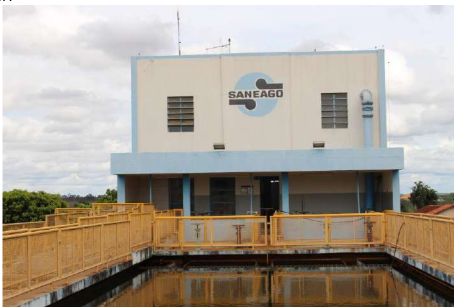
Figura 11: Vista parcial dos Decantadores.
