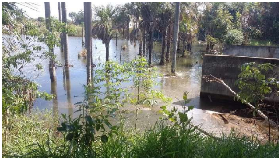
Figura 5: Tomada de Água Bruta – Canal de Concreto.
