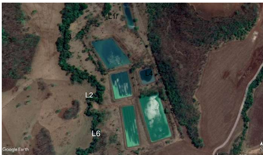
Figura 26: Estação de Tratamento de Esgoto de Goiatuba.
