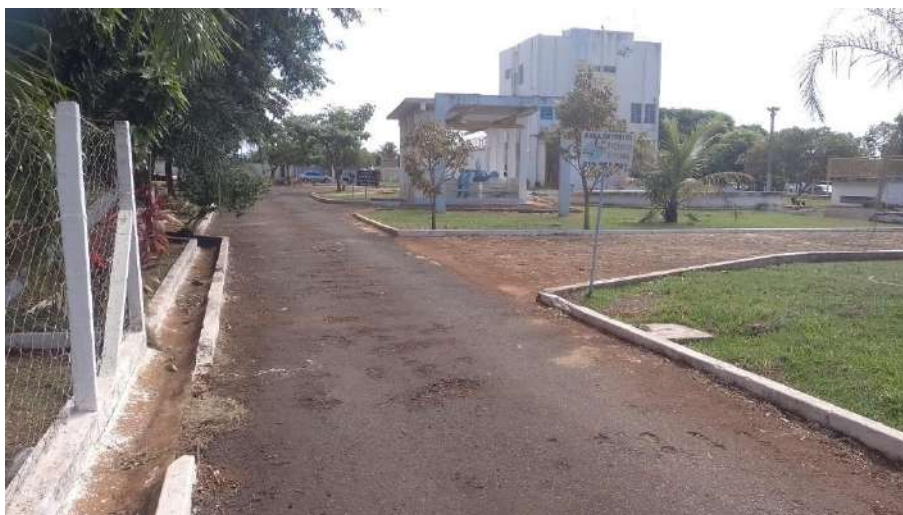
Figura 18: Reservatório Semi-enterrado – ETA - RST 1
